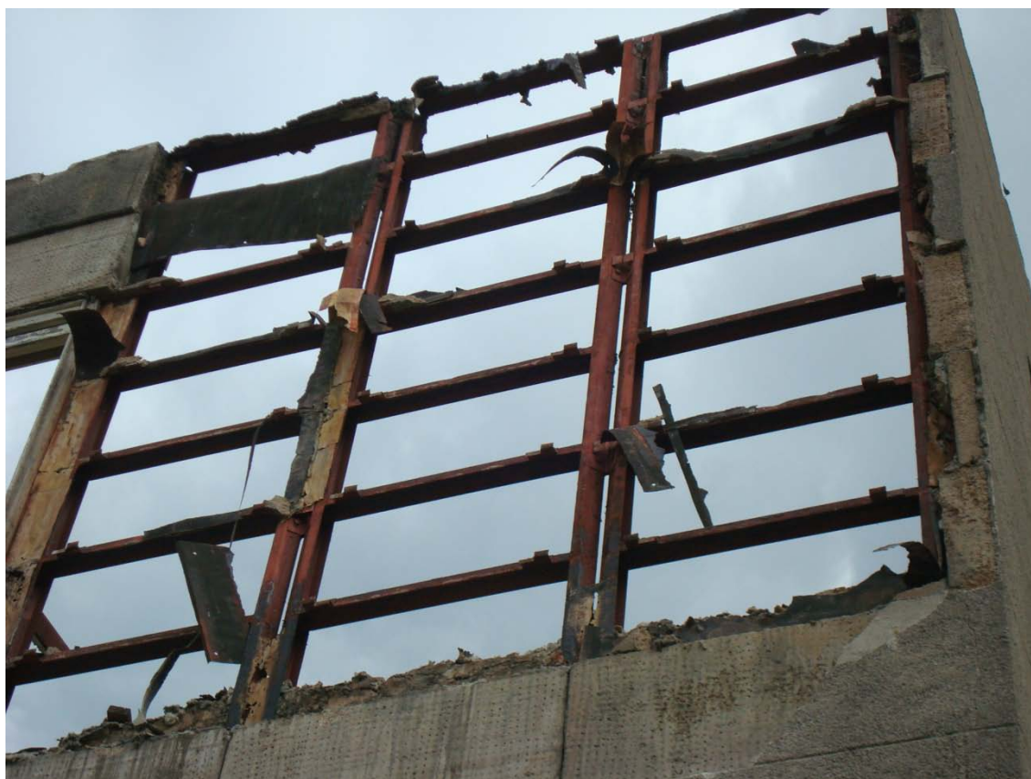
(15) Odhalená obvodová konstrukce
